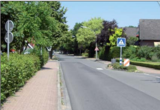
Schlechte Erkennbarkeit der Querung an der Mühlenstraße im Bereich der Grundschule und Kindergartens
