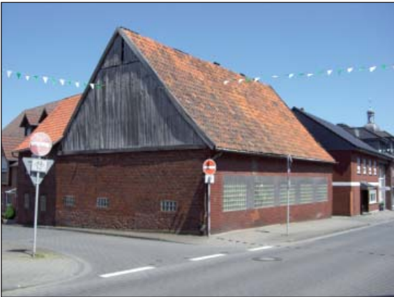
Ehemalige landwirtschaftliche Nebengebäude an der Bergstraße
