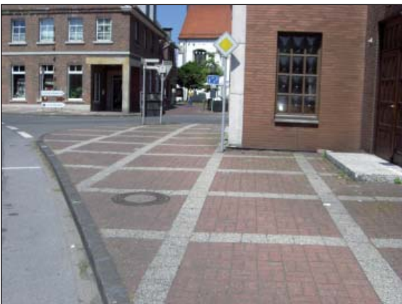
Platzbereich vor dem Haus Westermann
